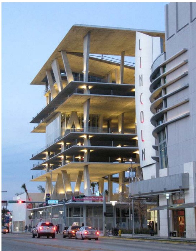
Parkeergebouw 1111 Lincoln Road, Miami, FL, Herzog & De Meuron
